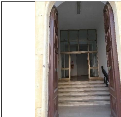
Particolare ingresso edificio Largo Strozzi
